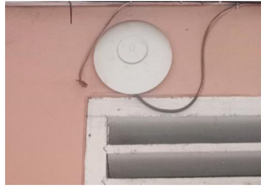
Gambar 8. Pemasangan Access point
